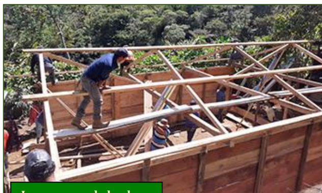
Los avances de la obra
