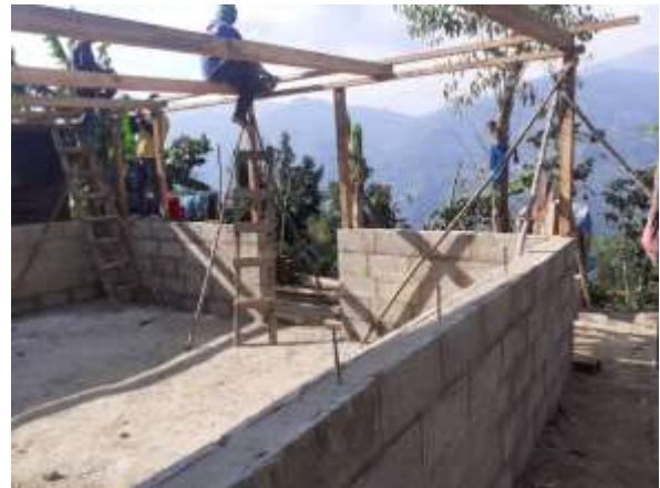
Los avances en la construcción
