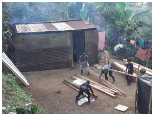
Preparativos para la construcción
