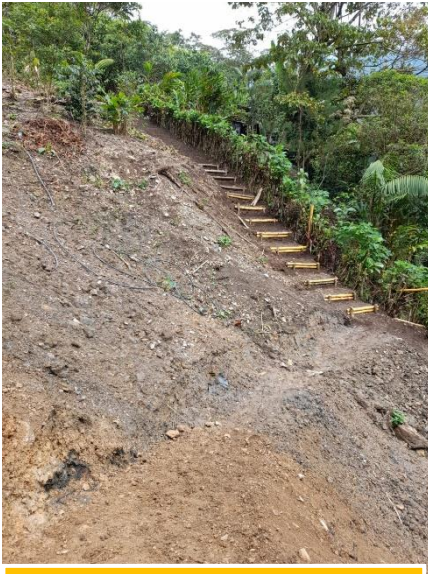
Acondicionando un acceso
