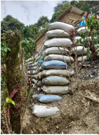
Un muro de contención, con los sacos llenos de cascajos
