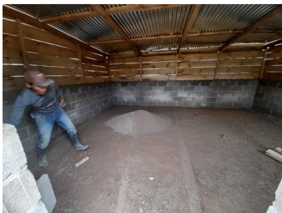
Interior de una vivienda, a punto de ser pavimentada con la capa de cemento
