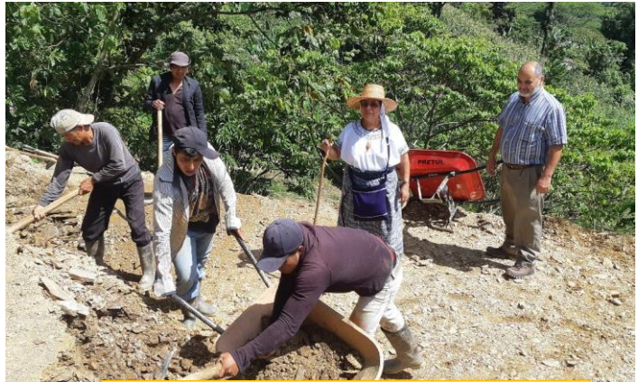
La cuadrilla de trabajadores, en plena faena
