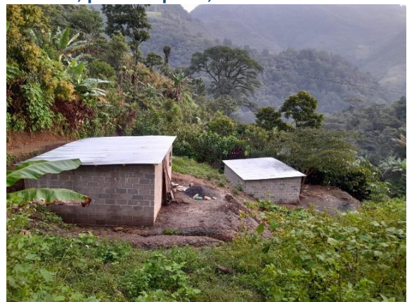
Las dos últimas viviendas, hechas ya con ladrillo
