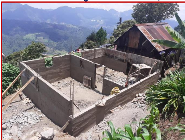
Los avances de la nueva construcción
