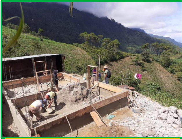
La nueva vivienda ya va tomando forma
