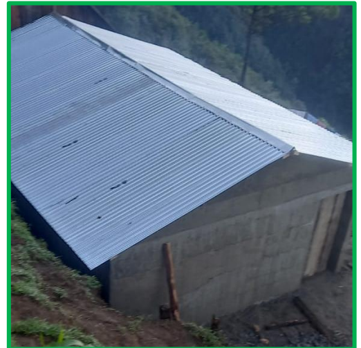
Techumbre de la nueva vivienda
