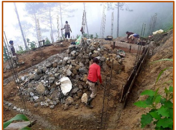
Los avances en la construcción de la nueva casa
