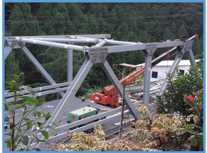
Las obras del puente, a punto de finalizar
