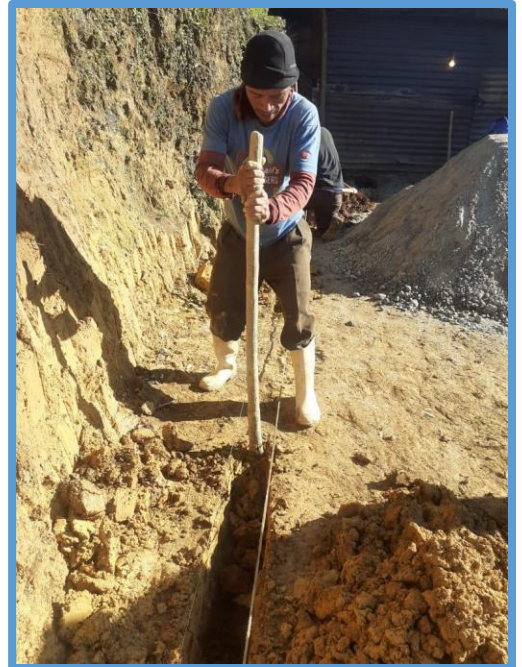
Preparando la zanja para los cimientos
