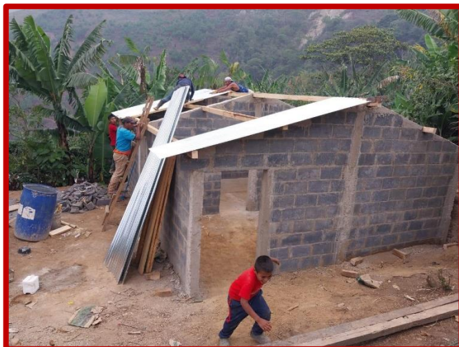
La vivienda para la familia Pop Cuz, ya casi terminada
