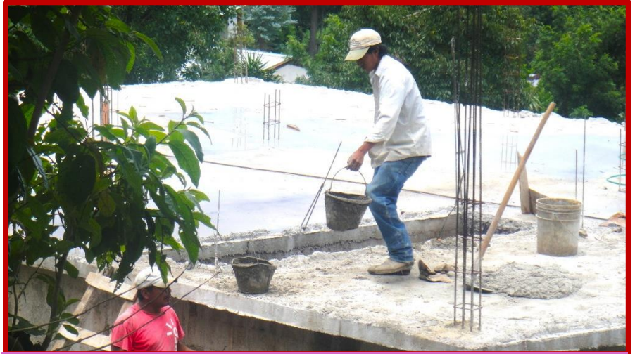
Preparando el pavimento para levantar el segundo nivel
